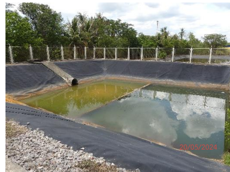
รูปที่ 2.2-8 บ่อน้ำทิ้งที่ผ่านการบำบัดจาก Oil Separator และบ่อ Holding Pond
