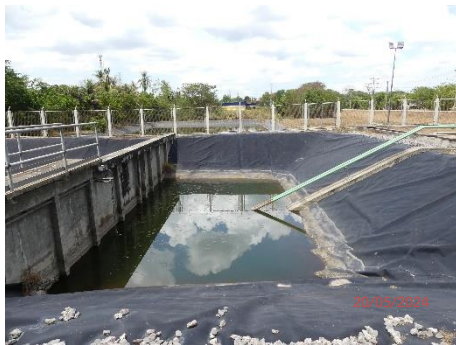
รูปที่ 2.2-8 บ่อน้ำทิ้งที่ผ่านการบำบัดจาก Oil Separator และบ่อ Holding Pond
